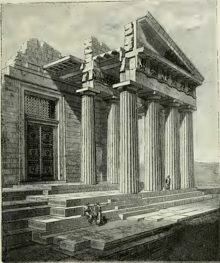
116. Aufbau der Nordostecke des Parthenon.
